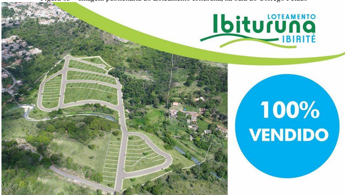
Figura 03 – Imagem publicitária do Loteamento Ibituruna, na baía do Córrego Pelado
