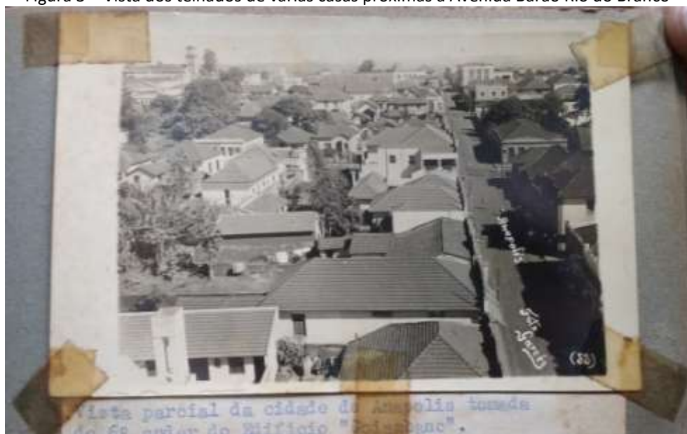
Figura 3 – Vista dos telhados de várias casas próximas à Avenida Barão Rio do Branco
