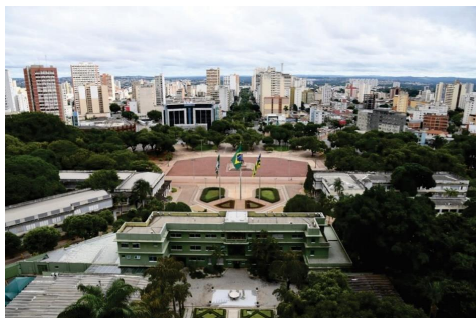
Figura 16: Praça Cívica após as intervenções de requalificação (2022) Fonte: Governo do Estado de Goiás 4
