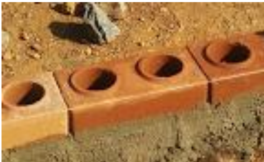
Figura 8 - Implantação do modelo pot-in-pot M1 utilizando alvenaria de tijolo ecológico Fonte: Autores, 2016
