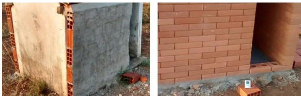
Figura 9 - Modelo convencional e novo modelo de alvenaria aplicando técnica de resfriamento. No novo modelo, observa-se aparelho de medição de temperatura interna e externa Fonte: Autores, 2016
