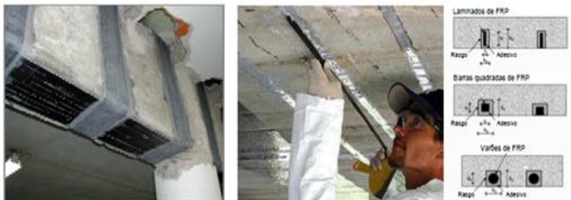
Figura 14 – Reforço de alvenaria através de duas técnicas de colagem de FRPs. Técnica EBR (com laminados e mantas) e Técnica NSR (com laminados) Fonte: Juvandes, 2011
