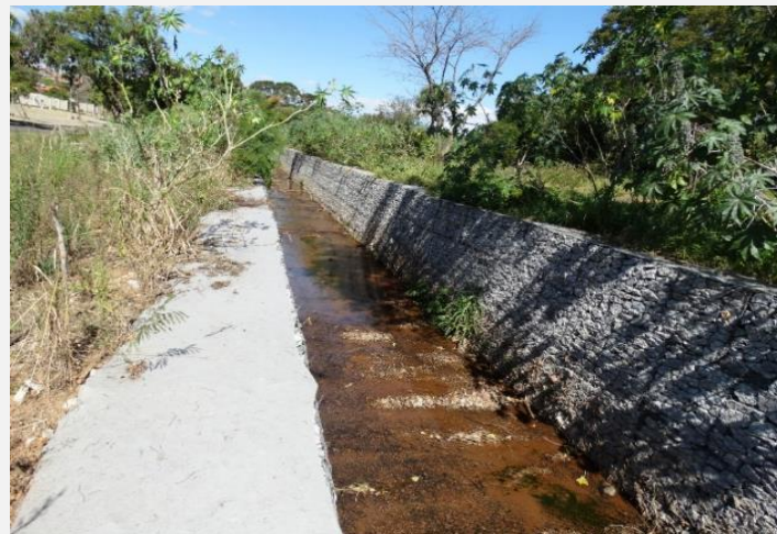
Figura 6 – Canalização do Córrego Água Fria no Bairro Jardim Europa. Fonte: Autores, 2017.
