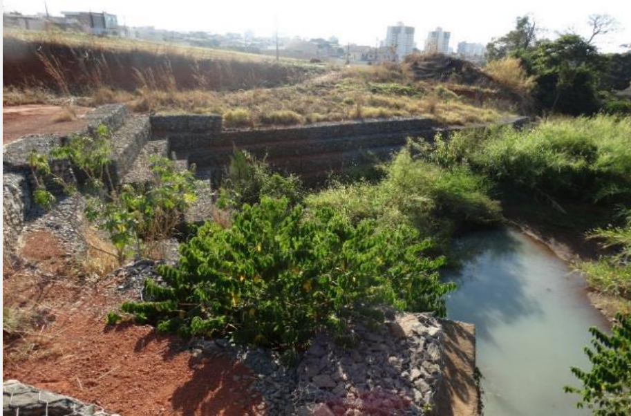
Figura 3 – Canalização de trecho do Córrego Água Fira em Anápolis (GO). Fonte: Autores, 2017.
