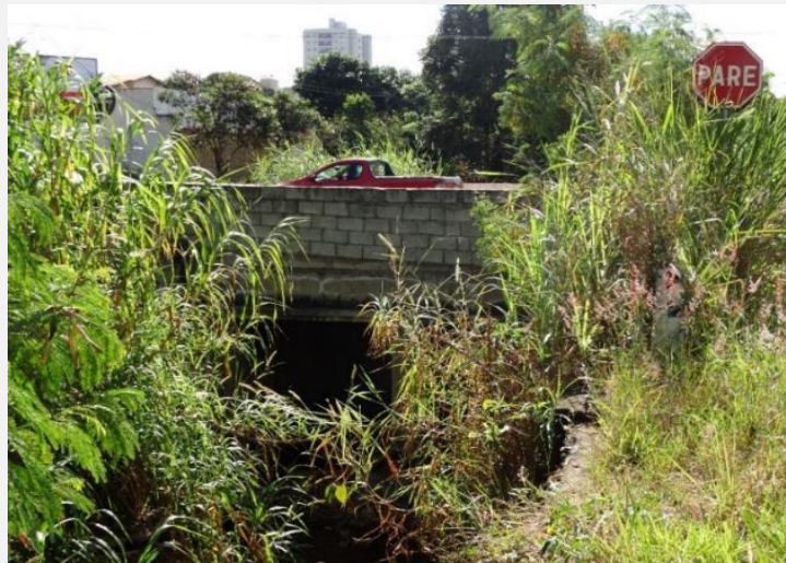
Figura 5 – Ponte no Bairro Jardim Europa. Fonte: Autores, 2017.
