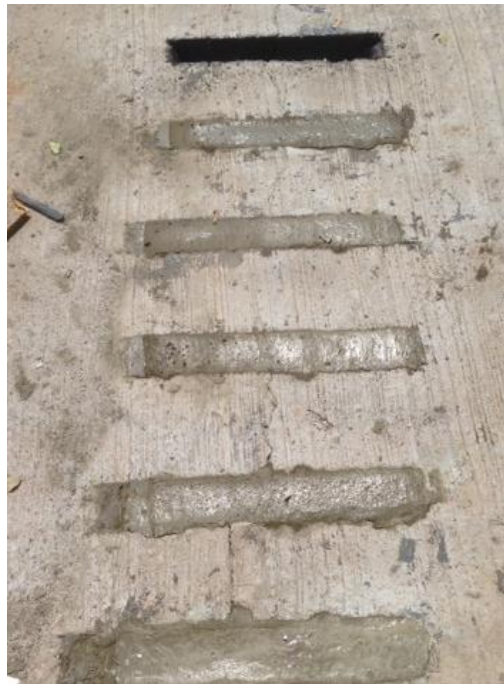
Figura 15. Preenchimento das valas com graute. Fonte: Autores, 2020.
