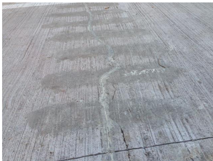
Figura 21. Estado do reparo de inserção de barras corrugadas (aço CA 50). Fonte: Autores, 2020.
