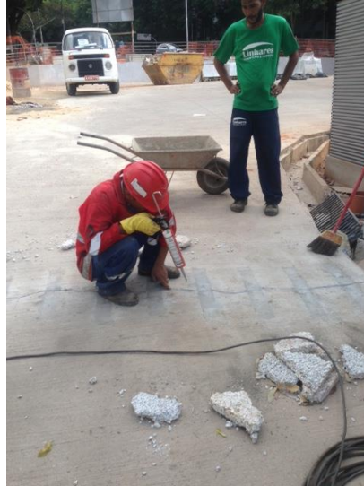
Figura 16. Preenchimento da fissura com poliuretano. Fonte: Autores, 2020.
