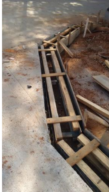
Figura 6. Geometria da placa com ângulo agudo e curva em poligonal. Fonte: Autores, 2020.
