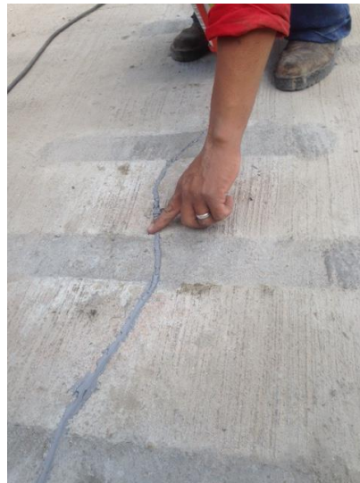
Figura 16. Preenchimento da fissura com poliuretano. Fonte: Autores, 2020.
